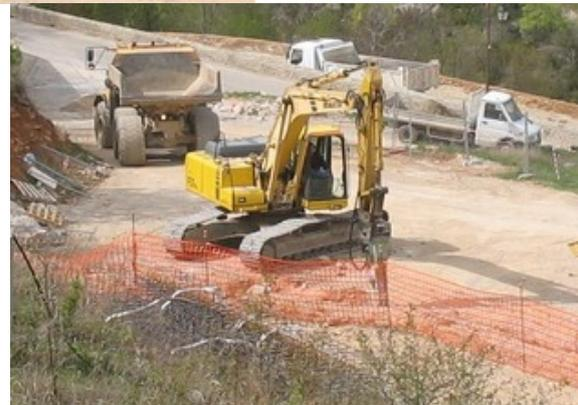
**Le brise roche et la pelleuse creusent des trous**
